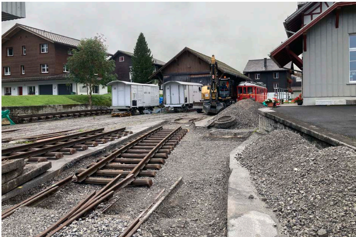
Verschiedene Gleisjoche liegen bereit für den Einbau auf dem Stationsareal in Elm, Aufnahme vom 21. August 2025. Bild: Jürg Vögeli
