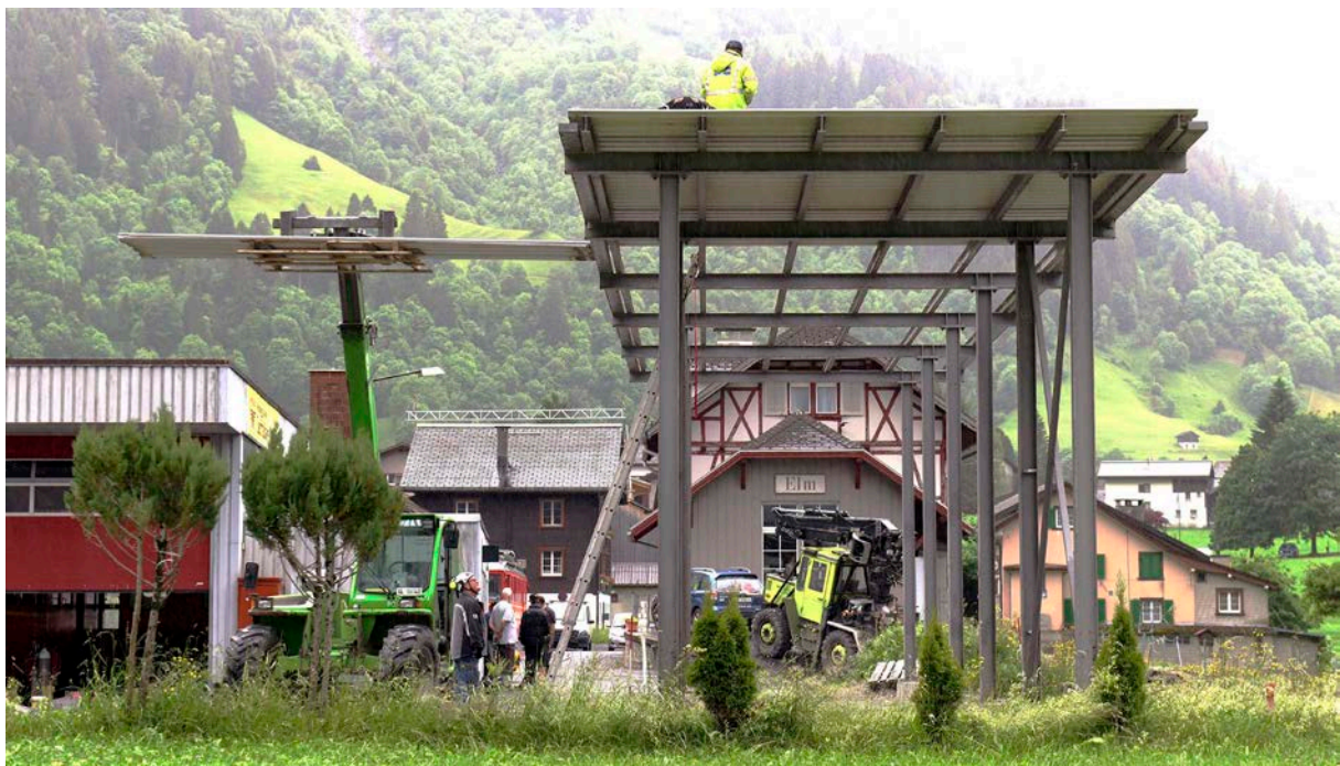
Montage der Dachbleche beim wiederaufgebauten Wagenunterstand in Elm, Aufnahme vom 4. Juni 2025. Bild: Comet Photoshopping GmbH, Dieter Enz
