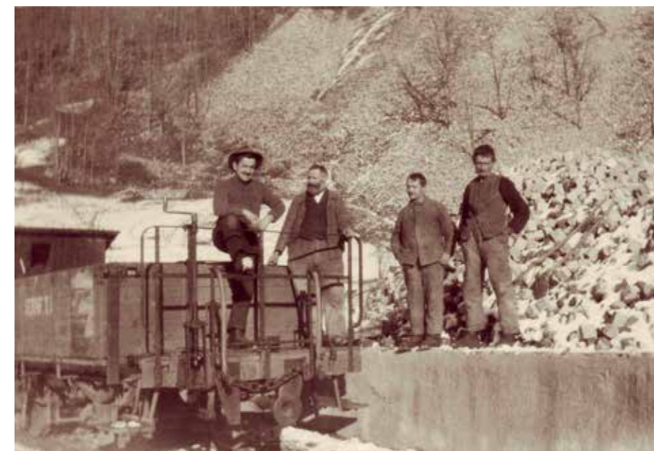
Undatierte Aufnahme von Arbeitern beim Steinbruch Bitzi
