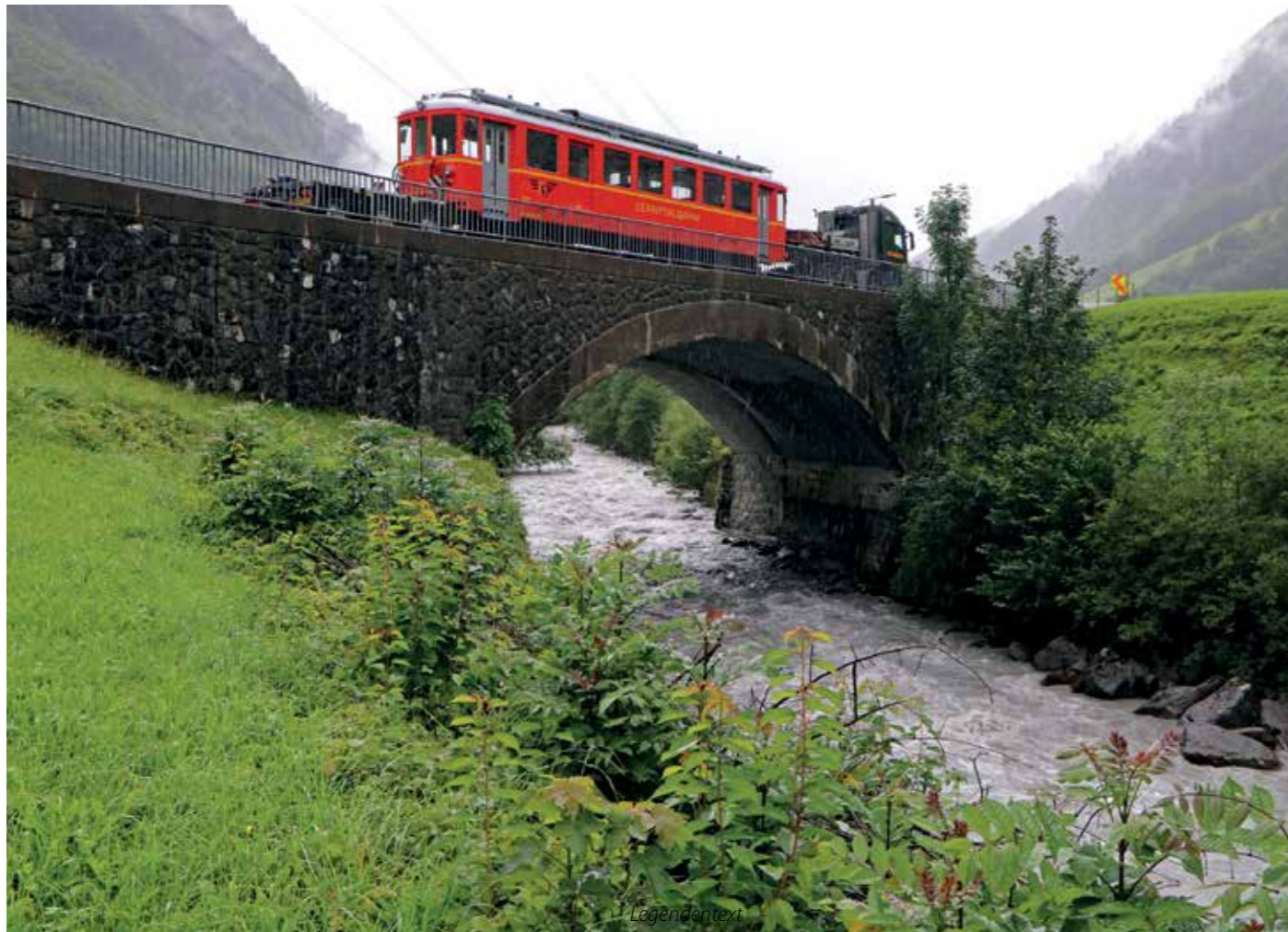
25.07.2017: Triebwagen Nr. 5 auf der Brumbachbrücke
