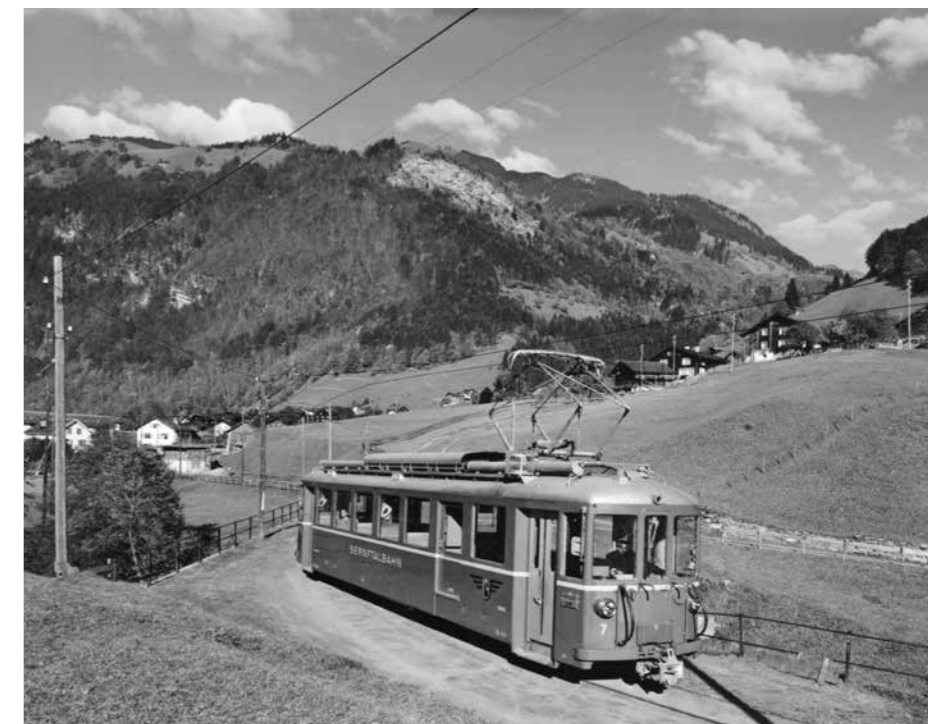
Triebwagen Nr. 7 bei der Brummbachbrücke
